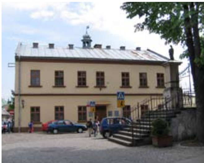
Fot. arch. MGOK w Starym Sączu
