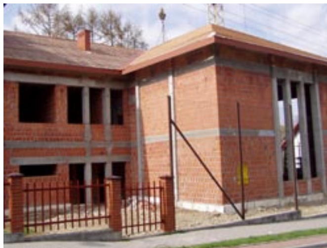
Budowa sali gimnastycznej przy szkole w Przysietnicy
