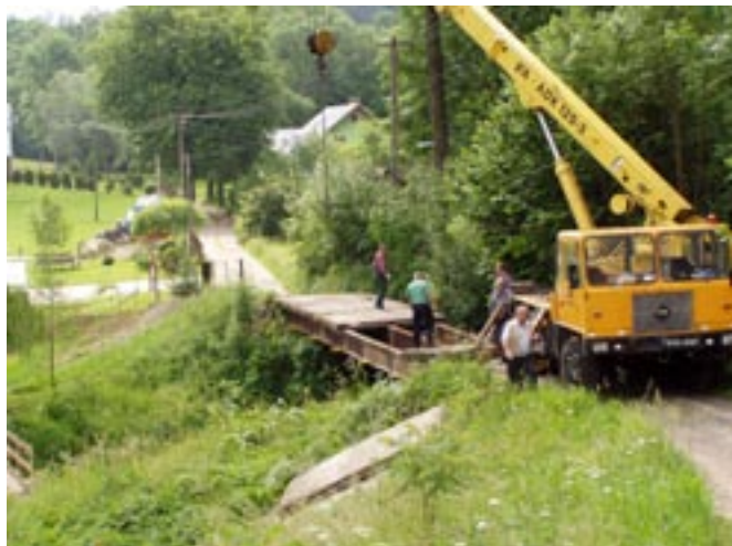
Naprawa mostu w Moszczenicy Wyżnej
